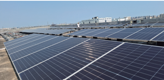
图 1：项目实景图照片
