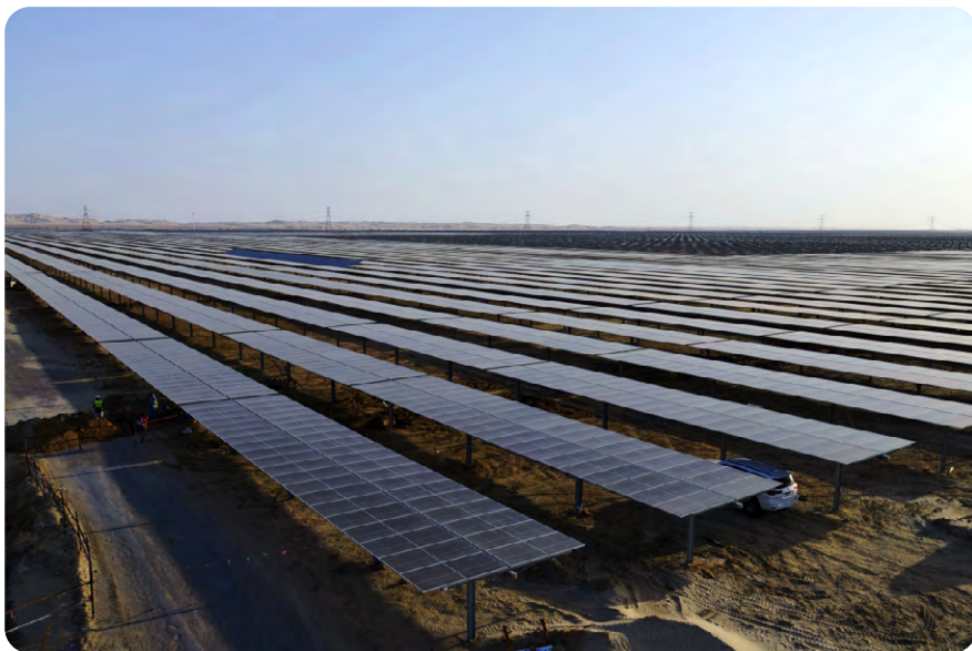
阿塞拜疆戈布斯坦100MW光伏项目
