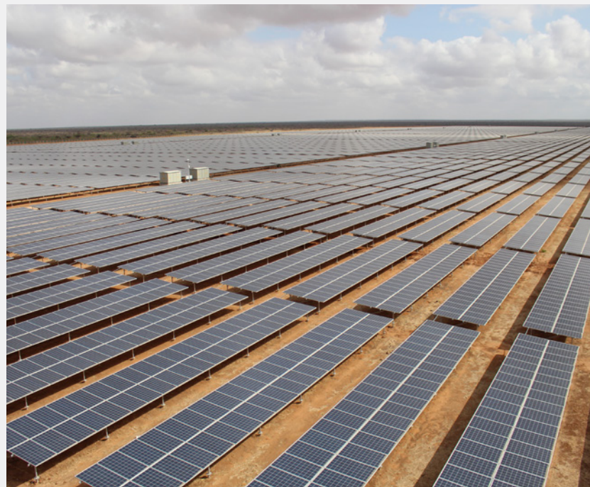
东非最大光伏电站——加里萨光伏电站
