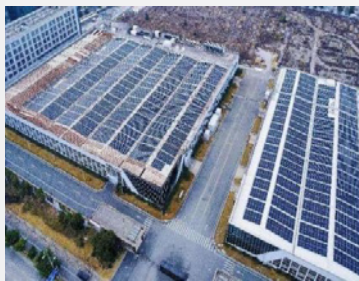
云南楚雄基地屋顶光伏系统
