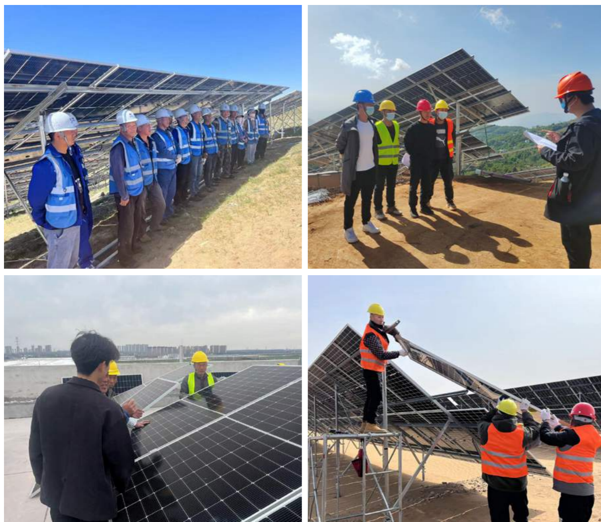
项目施工现场指导
