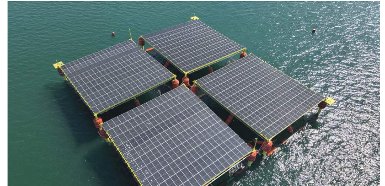
与中集来福士合作开发海上半潜漂浮式光伏平台，探索浮体结构及光伏组件在海洋环境下的耐候性和面对风浪的表现
