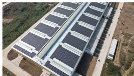
东博盛业 2MW BIPV 屋顶光伏项目
