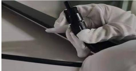
2. 接插连接器：接插连接器时需注意不可甩动线缆，以免砸伤组件；
